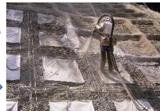
⑧法枠モルタル吹付
