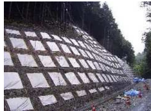
⑦枠内養生シート設
