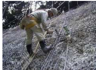
⑤2段目鉄筋、アンカー設置
