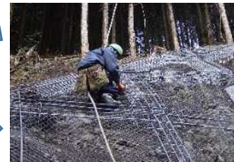
⑥モルタル、ダレ防止補助網設
