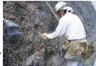
④RTフレーム設置
