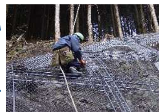
⑥モルタル、タレ防止補助網設
