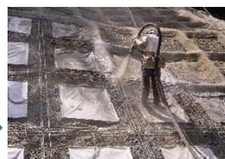
⑧法枠モルタル吹付
