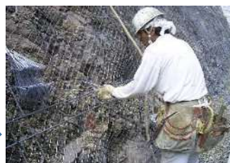
④RTフレーム設置
