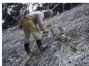
⑤2段目鉄筋、アンカー設置
